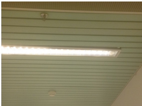
Lichtbak hangt uit het plafond.
