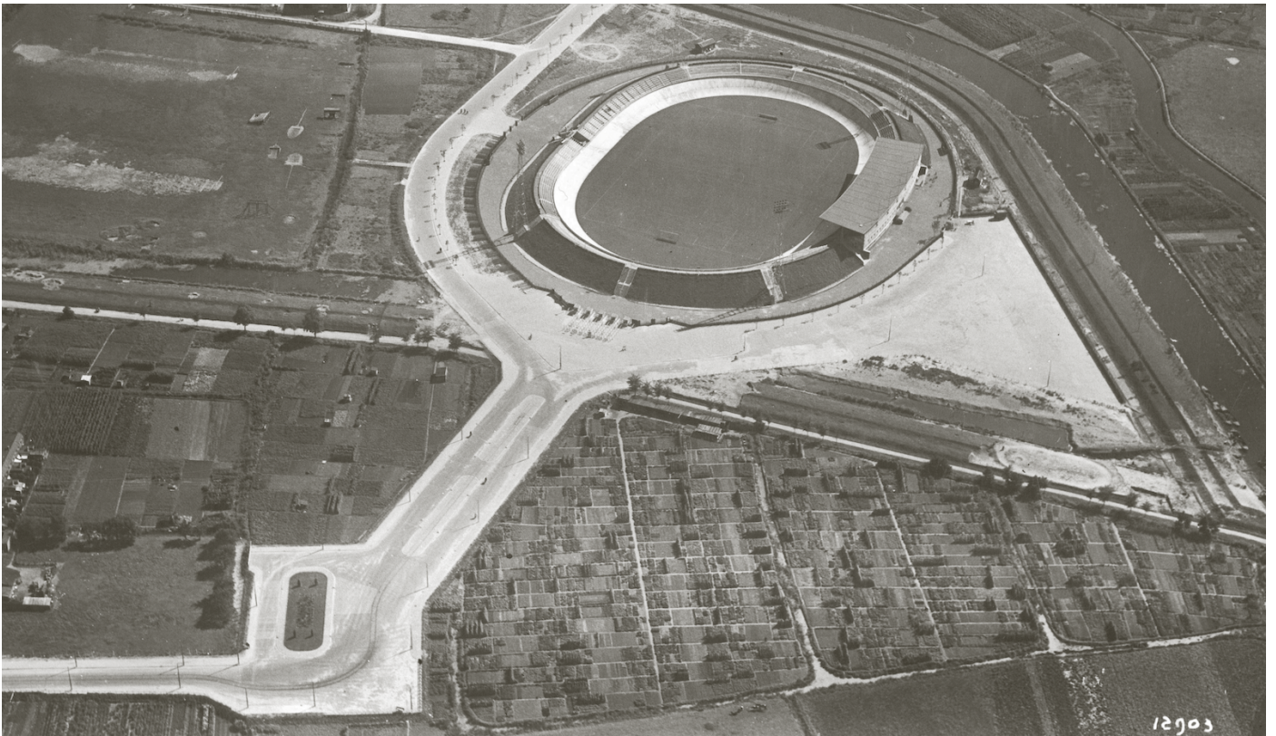
Galgenwaard stadion Utrecht, opening 1936 (werkverschaffingsproject)
