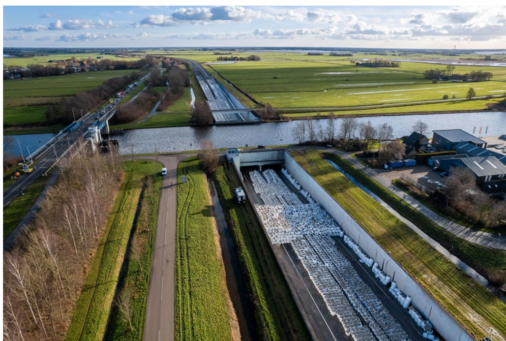
Overzichtsfoto vlak na afsluiten van de Prinses Margriettunnel met ballast (bigbags)
