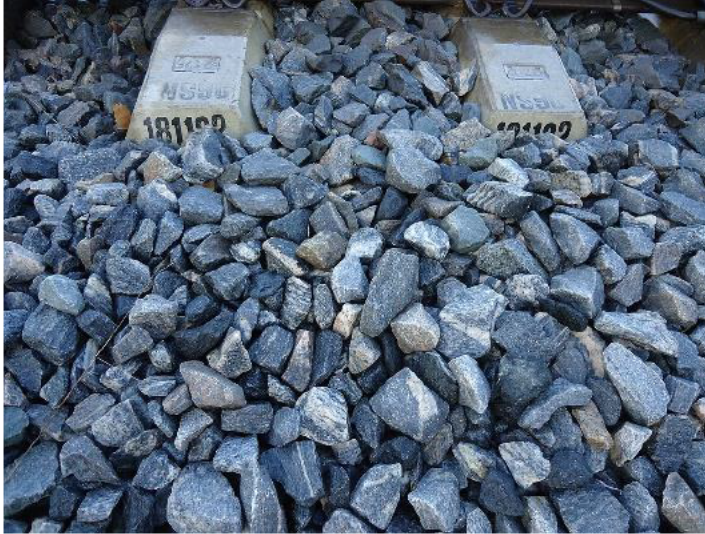
Figuur B2.1 Voorbeeld van ballastbed
