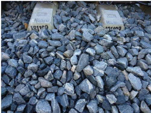
Figuur 6.4 Voorbeeld van ballastbed
