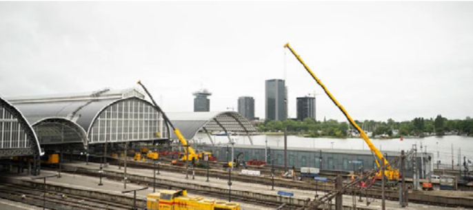
werkzaamheden op Amsterdam Centraal
