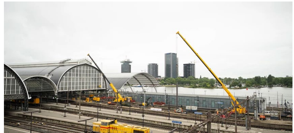
Werkzaamheden station Amsterdam Centraal (bron: prorail.nl)
