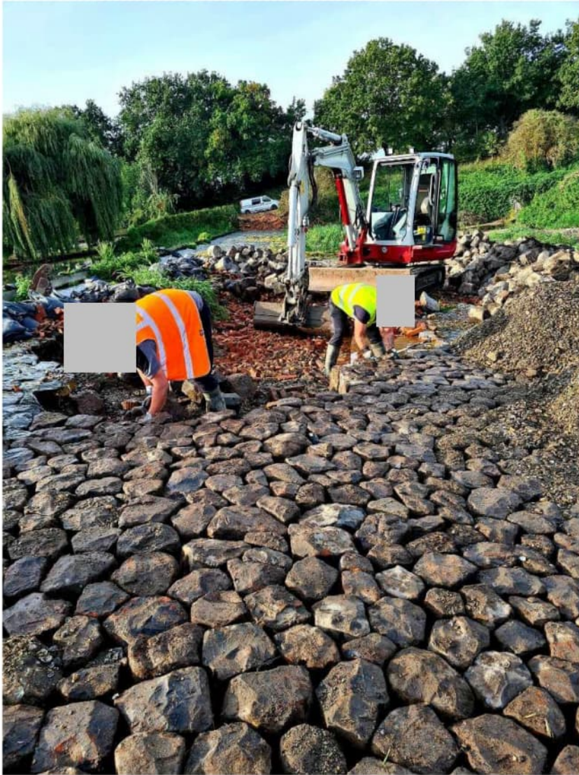
Figuur 4.8 Herstel bekleding met basaltzuilen.
