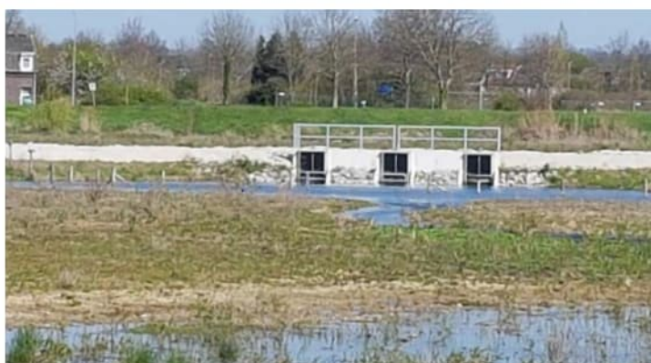
Figuur 6.1 De gerealiseerde inlaat met ontvangstvijver gezien vanuit het Bosscherveld (bron: Rijkswaterstaat, 2022).
