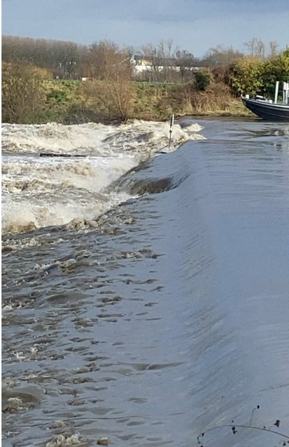
Figuur 4.12 Uitbreiding van de schade, 3 jan 24 12:16 uur.
