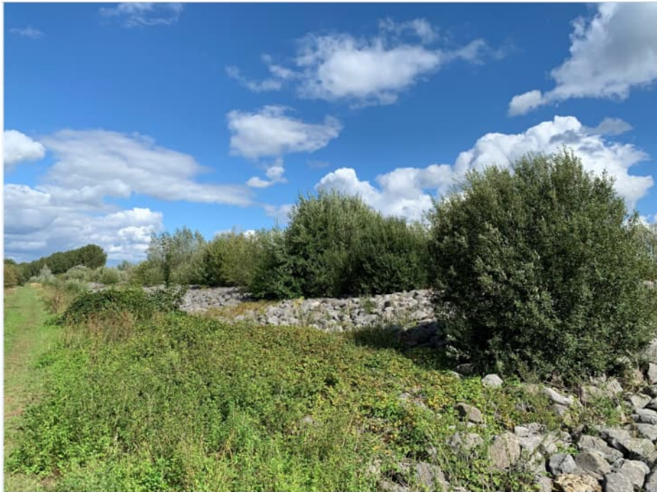
Figuur 6.13 Foto van de instroomdrempel van de noordelijke inlaat van Lateraal-kanaal west (benedenstroomse zijde). Datum onbekend.
