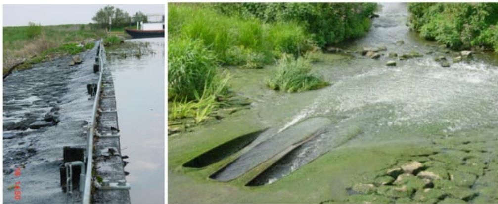
Figuur 2.7 Foto van de neerklapbare klep (links) gemonteerd op de oudere reeds bestaande balk. Het mechanisme om de klep omhoog te houden is zichtbaar; terwijl de wijze waarop deze vastgezet wordt in neergeklapte positie niet te zien is. Aan de rechterkant van de afbeelding zijn de drie 'doorlaat' buizen in de overlaat te zien van bovenaf (bron: RWS, 2022).
