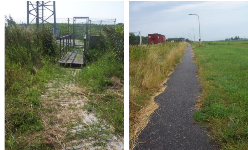
Figuur 1.3 Onderdelen van het geïnspecteerde areaal
