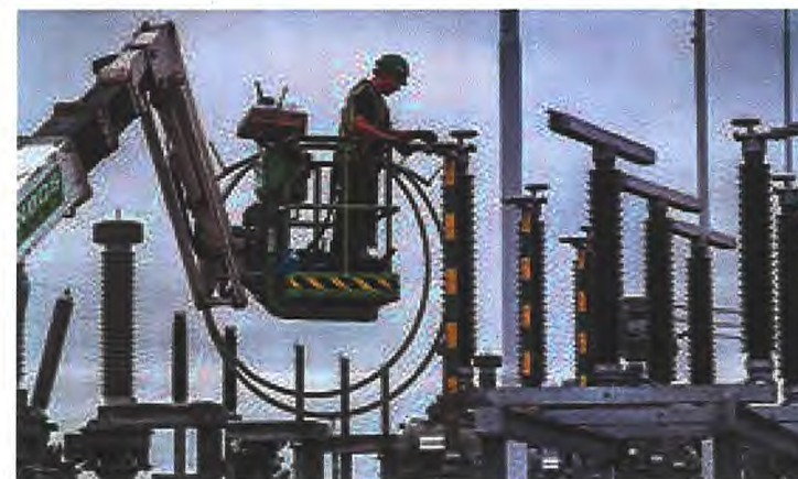
380 kV hoogspanningsverbinding bovengronds wordt aangelegd.
