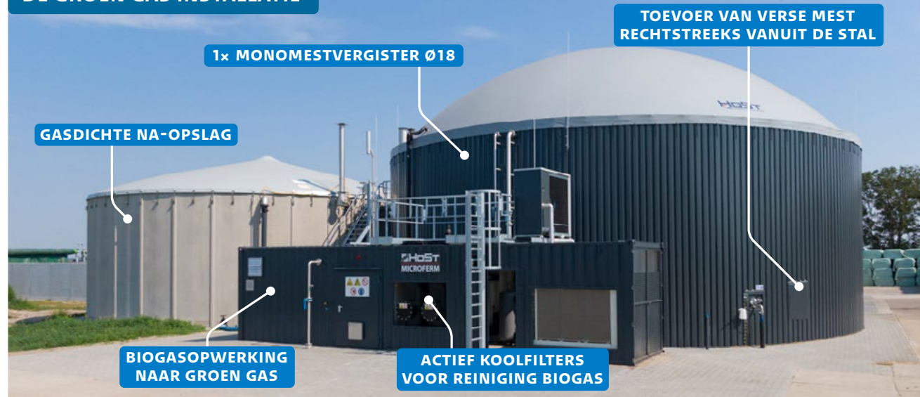
FIGUUR 7 | Voorbeeld van een biogasinstallatie
