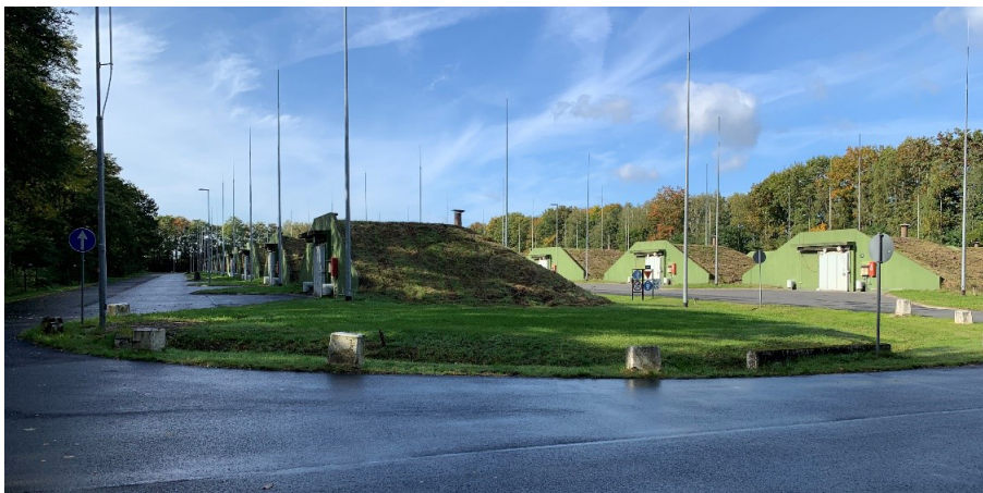
Afbeelding 1 Munitiebunkers voor opslag (bron: IVD).
