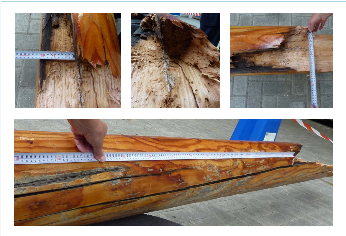
Figuur 9: Windscheuren en breukvlak in de giek van de Risico.
