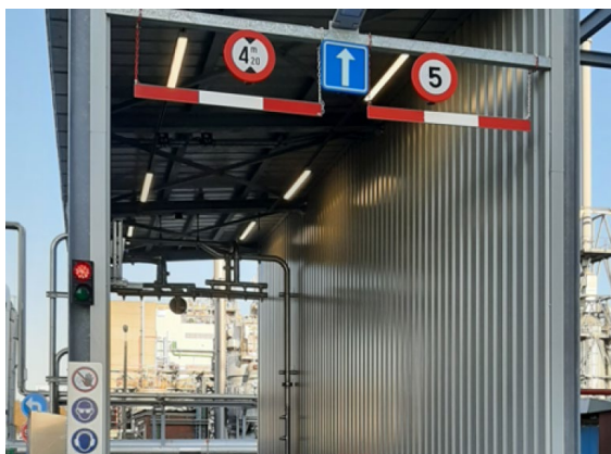
Figuur C: (links) Een afblaastunnel voor het afblazen van kunststofgranulaat van vrachtwagens 42
