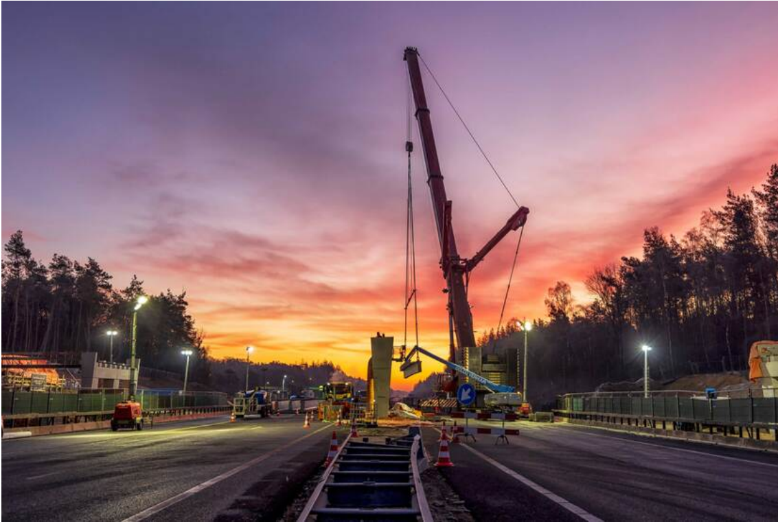
Foto Werkzaamheden aan viaduct Hoog Burel
