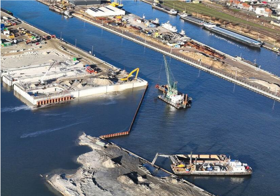
Foto Nieuwe sluis bij Terneuzen 2023
