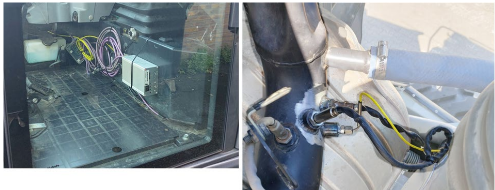
Figuur 3: Voorbeeld van een geïnstalleerde SEMS met sensor in de uitlaat.
