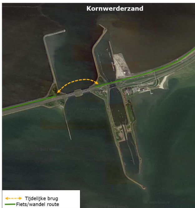
Figuur 22: Brug waddenzeezijde Kornwerderzand.
