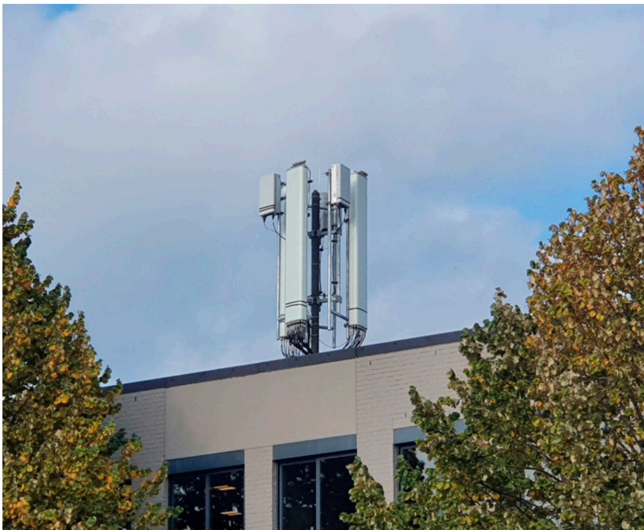
Figuur 4: 5G NR-antenne basisstation met een drietal sectoren. De kleine antennes zijn voor de 3,5 GHz band. Bron: KPN.
