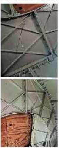
Werkzaamheden aan de toren van de Lange Jaap.
