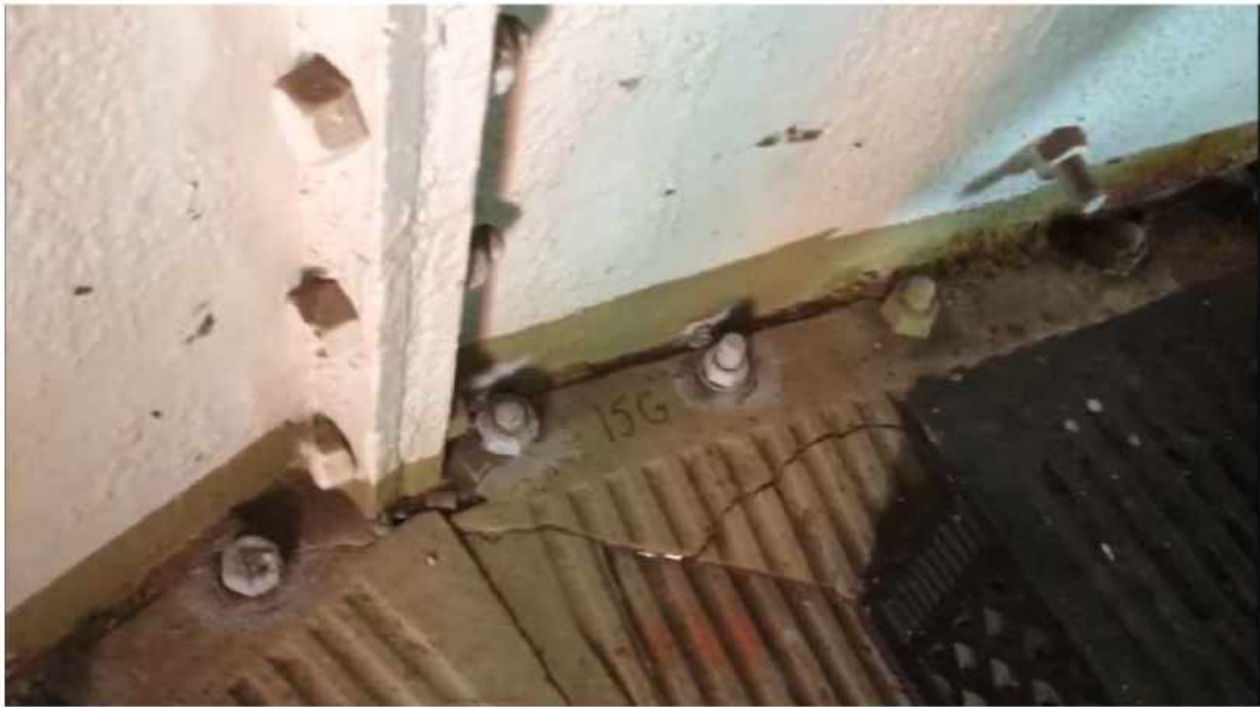
Figuur 6: bezwaken vloer op niveau 15 nabij transportroute
