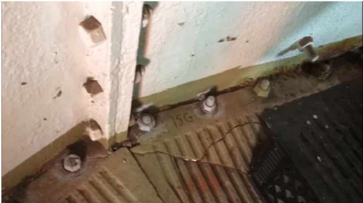
Figuur 6: bezwaken vloer op niveau 15 nabij transportroute
