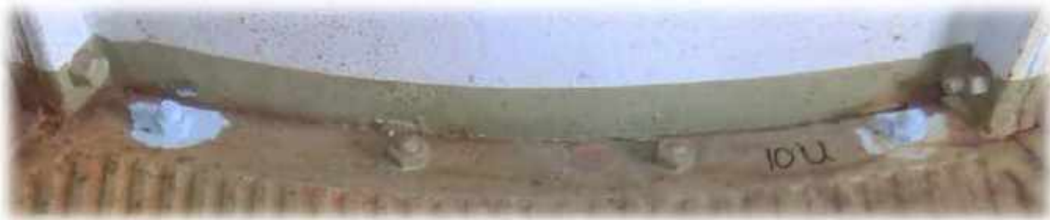
Status vloerplaat 10U op 21 juni 2011
