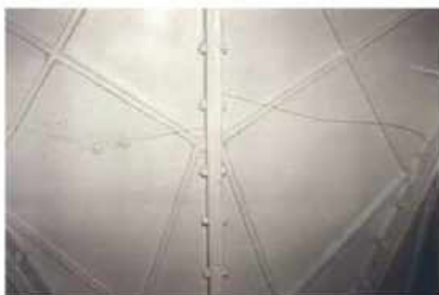
Foto 3, scheurvorming vloer (v.a. onderzijde)
