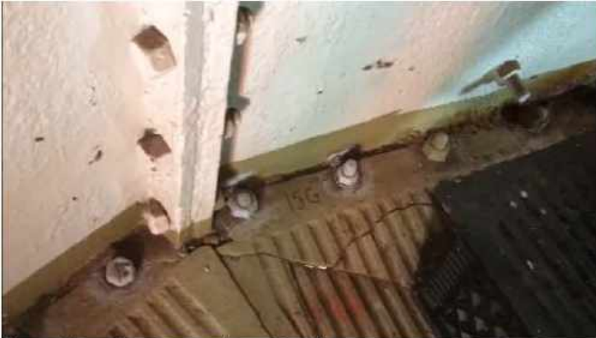
Figuur 6: bezwaken vloer op niveau 15 nabij transportroute
