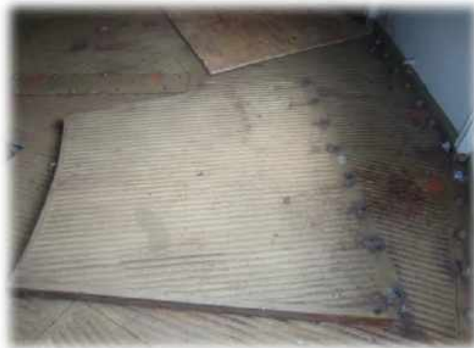
Vloerplaat 9A, uitgenomen
