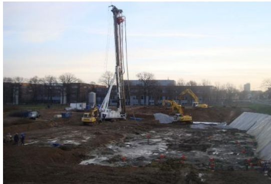
Figuur 30. Nieuwbouw scholencomplex met aangepaste, versterkte fundering.
