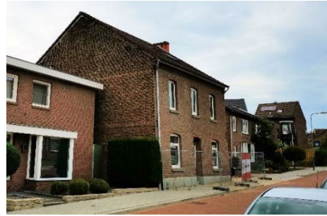
Figuur 9. Woning Bosweg afgebroken en herbouwd.
