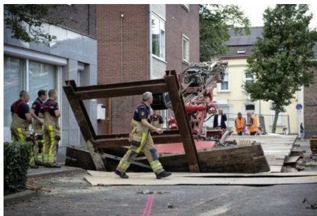
Figuur 19. Breuk van het veiligheidsplatform door het gewicht van de boormachine (Bron: De Limburger, Bas Quaedvlieg).
