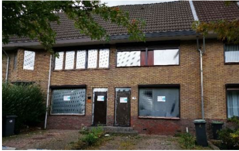
Figuur 8. Aantal woningen Gulikstraat ontruimd.
