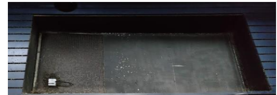
Figuur 9: Vervuild en deels afgeblind afzuigrooster zaal.
