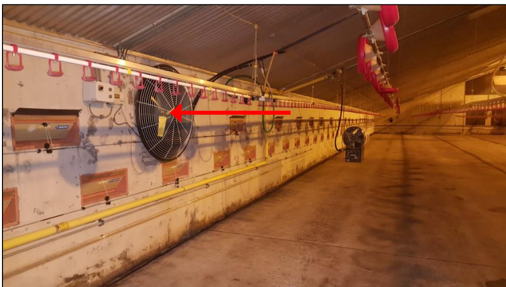
Inlaat van de warme/vuile stallucht naar de warmtewisselaar. Tevens inlaatventielen en drinklijn zichtbaar
