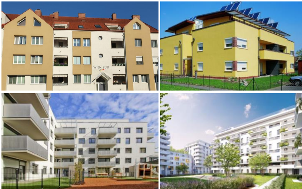
Complexen van Wien-Süd uit verschillende bouwperiodes. Boven: 1990 (l) en 2007 (r). Onder: 2017 (l) en 2021-2023 (r)
