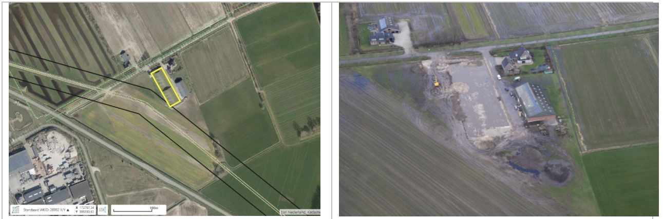
Figuur 17: Links de situatie in gemeente Laarbeek op de luchtfoto 2020 met panden aanwezig op de rand de SVB-strook. Rechts de situatie in maart 2021 vanuit de lucht waargenomen waarbij de betreffende panden gesloopt zijn. Deze locatie ligt vlak bij het geplande Zonnepark de Blauwe Poort.
