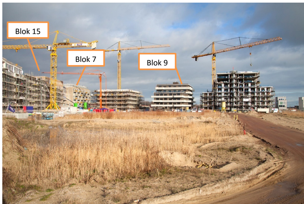
Figuur 3 Overzicht projecten in aanbouw - Foto Rogier Alleblas
