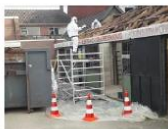
Foto: Overzicht steiger
