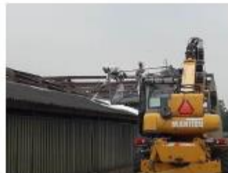
Foto: golfplaten inspuiten met schuim
