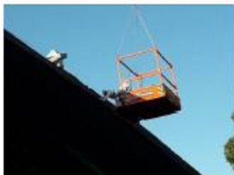
Foto: Golfplaten verwijderen
