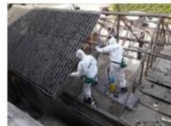
Foto: Golfplaat verwijderen
