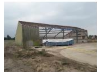
Foto: Positie container
