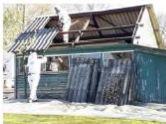
Foto: Golfplaten verwijderen
