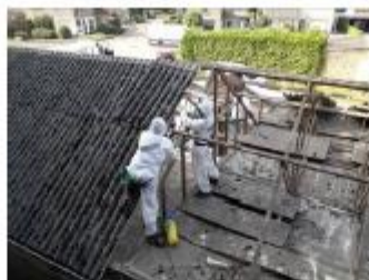
Foto: Golfplaat verwijderen
