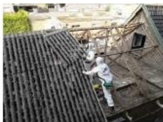
Foto: Golfplaat verwijderen
