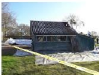
Foto: Overzicht golfplaten dak
