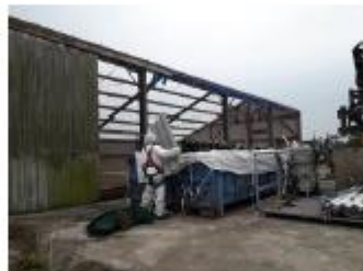
Foto: losse golfplaat in container gooien
