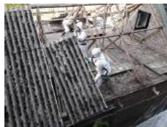
Foto: Golfplaat verwijderen
