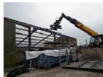
Foto: golfplaten in container hijsen
