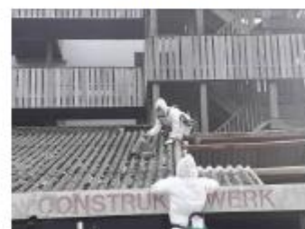
Foto: Nokvorsten naar beneden schuiven
