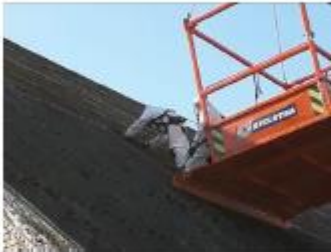
Foto: Golfplaten verwijderen
