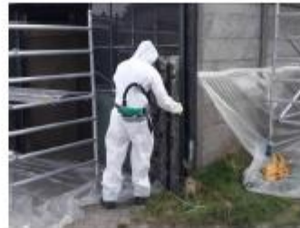
Foto: Golfplaat verzamelen tegen gevel
