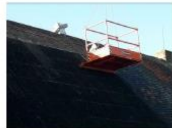
Foto: Golfplaten loschroeven
