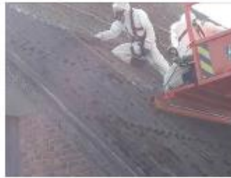
Foto: Golfplaten verwijderen
