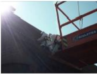
Foto: Golfplaten verwijderen
