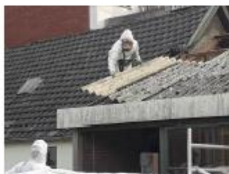
Foto: Golfplaat verwijderen
