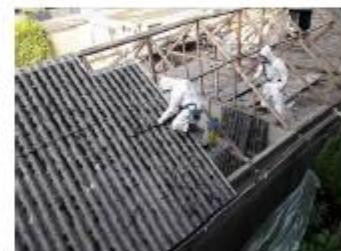
Foto: Golfplaat verwijderen
