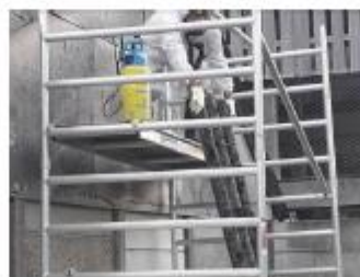
Foto: Golfplaat doorsteken
