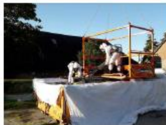
Foto: Golfplaten in container schuiven
