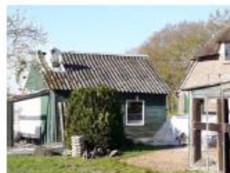
Foto: Golfplaten los schroeven
