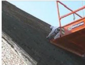
Foto: Golfplaten los schroeven
