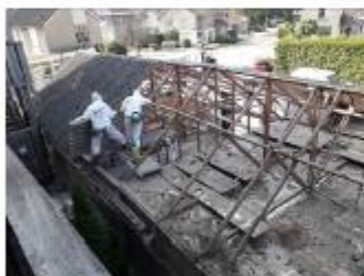
Foto: Golfplaat schuiven over loopplank
