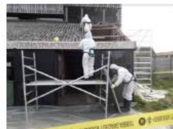
Foto: Golfplaten naar container brengen
