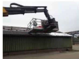
Foto: golfplaten inspuiten met schuim
