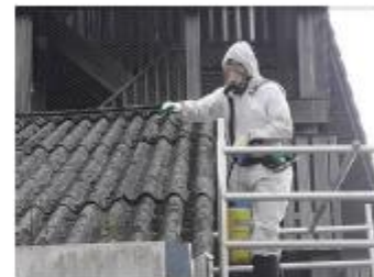
Foto: Dak benevelen
