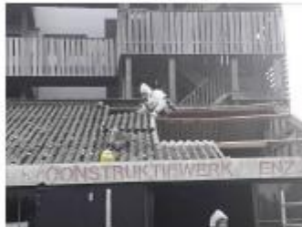
Foto: Golfplaat naar beneden schuiven
