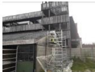
Foto: Dak benevelen
