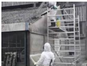
Foto: Golfplaat verwijderen
