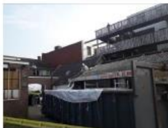
Foto: Golfplaten verwijderen
