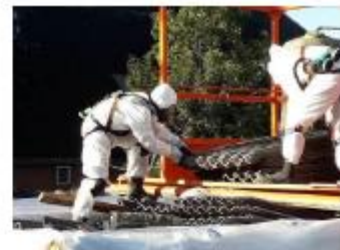
Foto: Golfplaten in container schuiven
