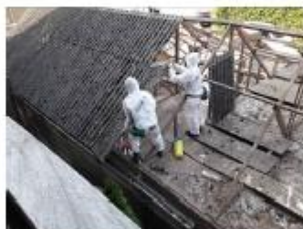
Foto: Golfplaat verwijderen
