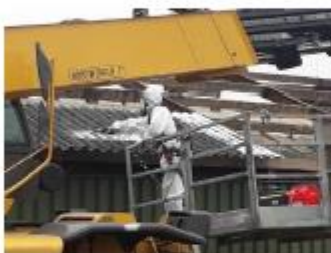
Foto: golfplaten inspuiten met schuim
