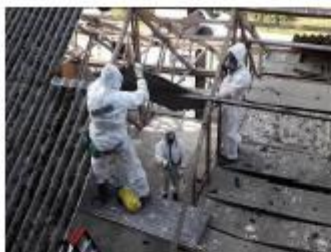
Foto: Golfplaat schuiven over gording
