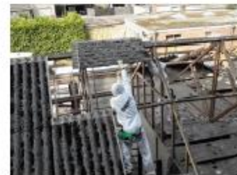
Foto: Loswrikken golfplaat
