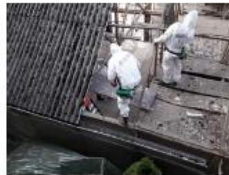
Foto: Golfplaat doorsteken
