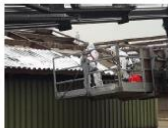
Foto: golfplaten verwijderen
