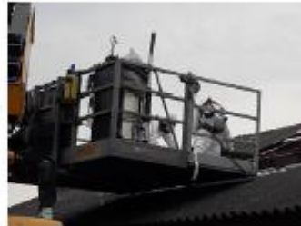
Foto: golfplaten verwijderen
