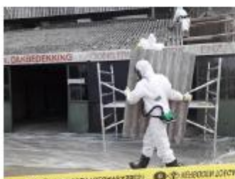
Foto: Golfplaten naar container brengen
