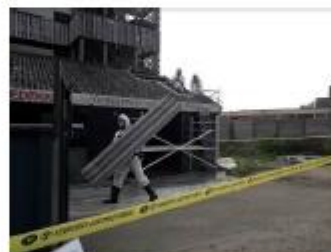
Foto: Golfplaten naar container brengen
