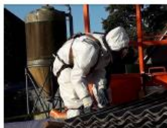
Foto: Golfplaten in container schuiven
