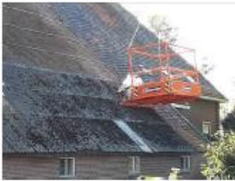
Foto: Golfplaten los schroeven
