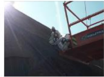
Foto: Golfplaten verwijderen
