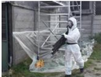
Foto: Golfplaat weglopen
