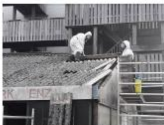
Foto: Golfplaten verwijderen
