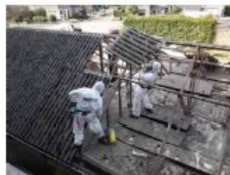
Foto: Golfplaat verwijderen
