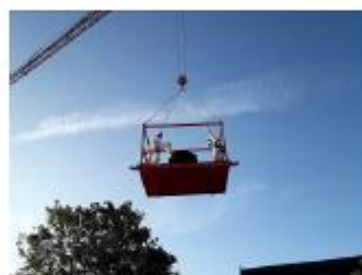
Foto: Nokvorsten naar container brengen
