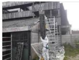
Foto: Golfplaat langs steiger schuren
