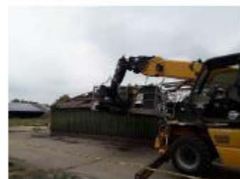
Foto: golfplaten los schroeven
