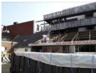
Foto: Schuiven golfplaten
