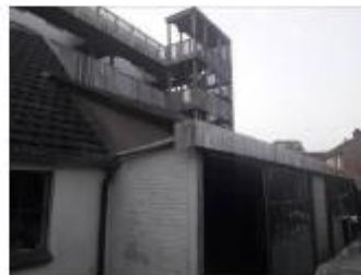
Foto: Overzicht woning naast schuur
