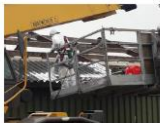
Foto: golfplaten inspuiten met schuim
