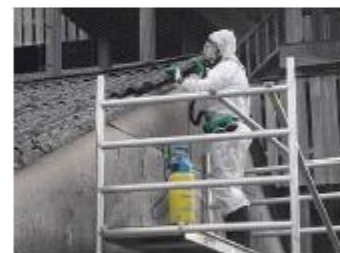
Foto: Golfplaat verwijderen
