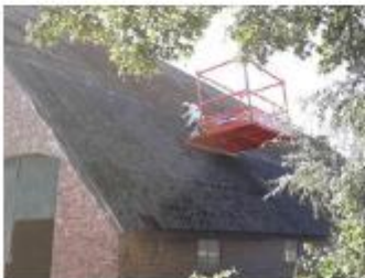
Foto: Golfplaten verwijderen
