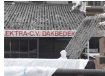
Foto: Golfplaten over steiger schuiven
