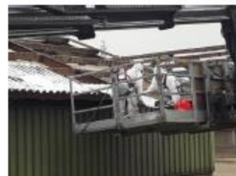
Foto: golfplaten verwijderen
