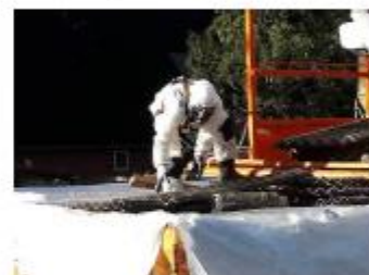
Foto: Golfplaten in container schuiven
