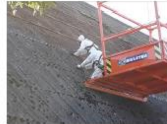
Foto: Golfplaten losschroeven en restanten verwijderen
