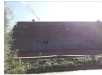
Foto: Overzicht na sanering
