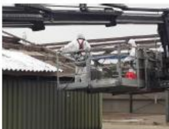
Foto: golfplaten verwijderen
