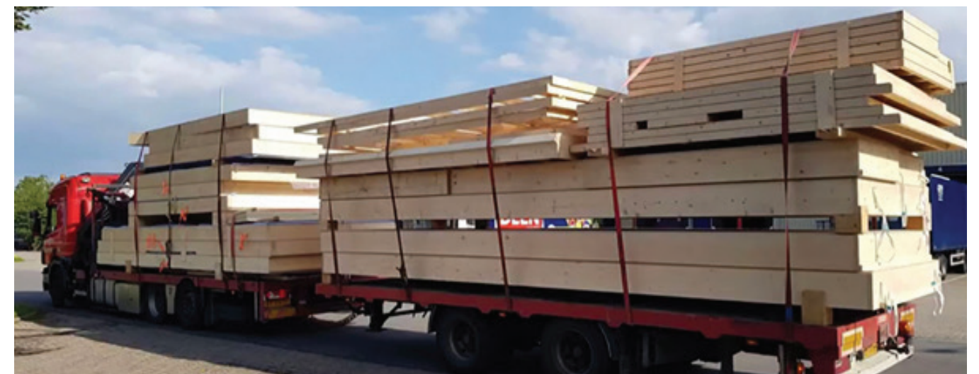
Afb. 2.2 Transport van alle CLT-elementen voor één woning Bron: Orga Architect
