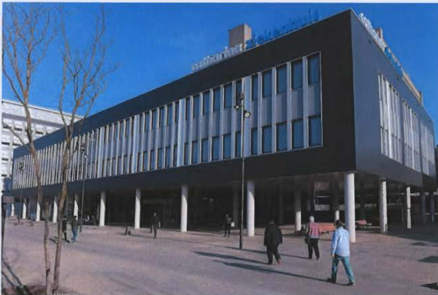
Ver- en nieuwbouw diverse bouwdelen Catharina Ziekenhuis, Eindhoven in opdracht van Catharina Ziekenhuis
