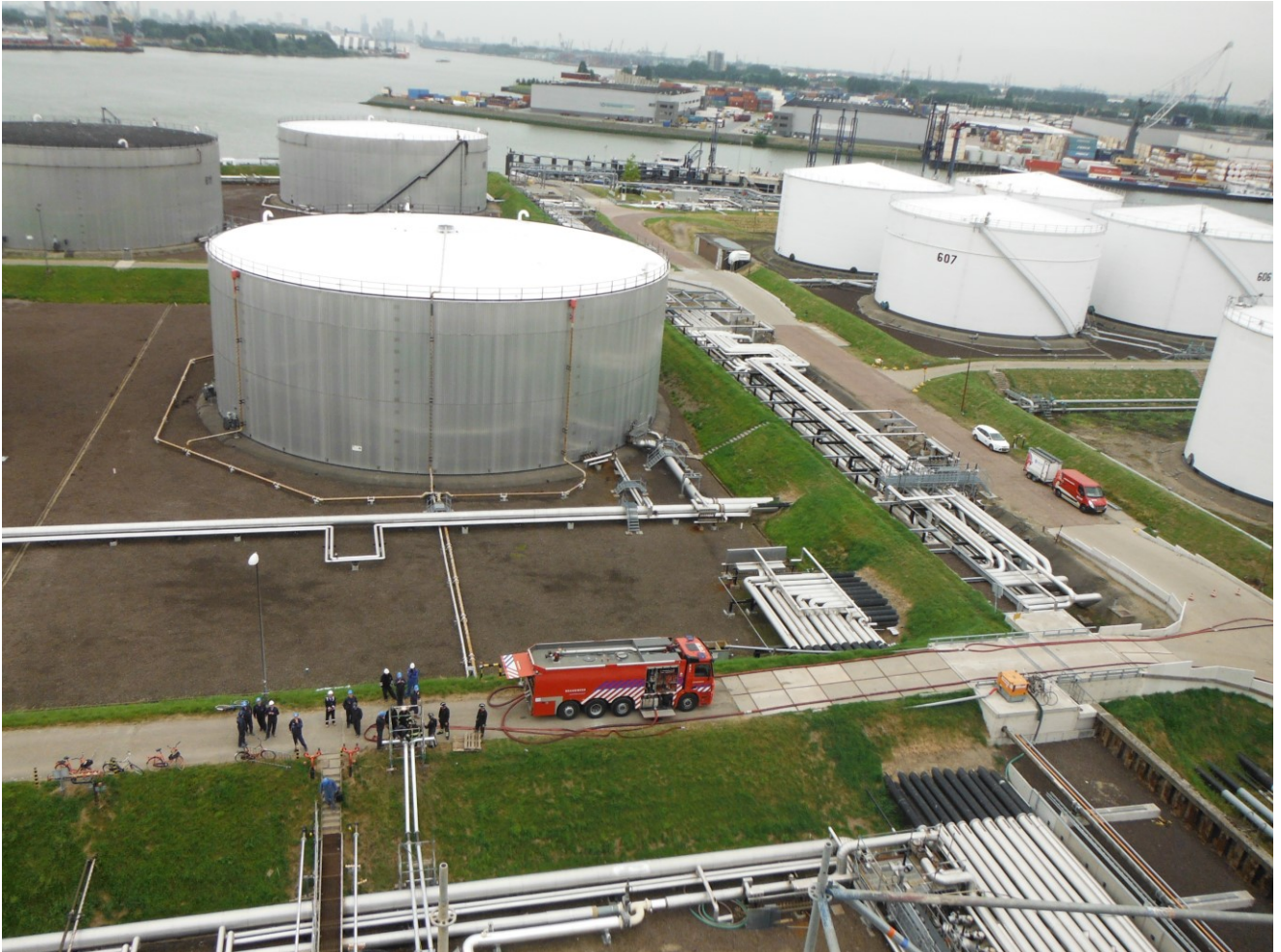
Brandweertest bij opslagterminal
