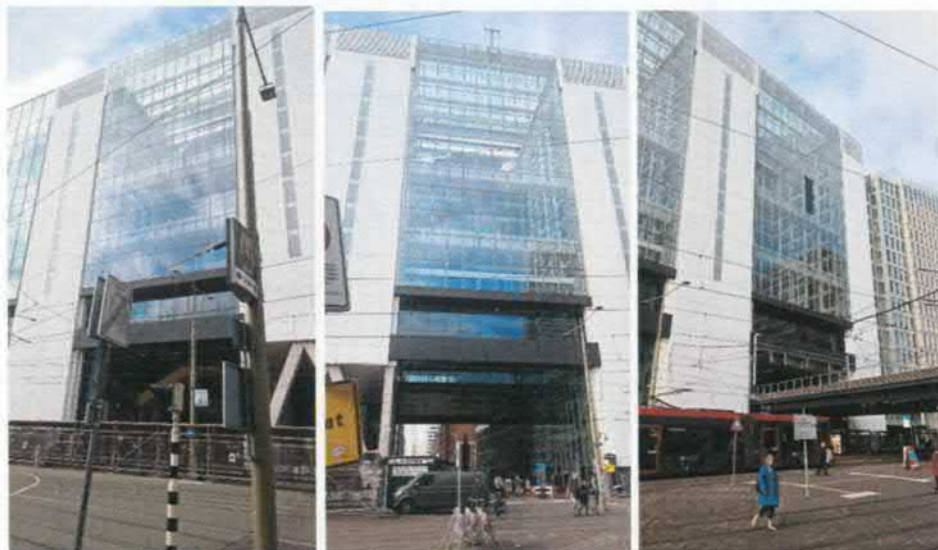
Figuur 3.1: Overzicht van de drie geveldelen ter plaatse van de atria; van rechts naar links vak 1, 2 en 3
