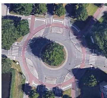
Fietspad rond rotonde
