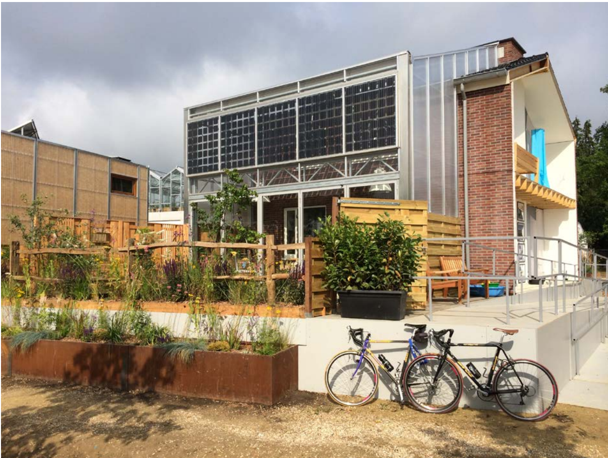
Figuur 2.1: Het Prêt-à-Logerhuis, inzending van het studententeam van de TU Delft voor de Solar Decathlon Europe 2014 in Versailles: een oorspronkelijk energieverpillend, ongezond, krap rijtjeshuis uit 1960 dat met duurzaamheidsingrepen energieneutraal, comfortabel, ruimer en ecologisch waardevol werd. Het prijswinnende ontwerp is nu nog te bezichtigen op The Green Village, het experimenteerterrein van de TU Delft.
