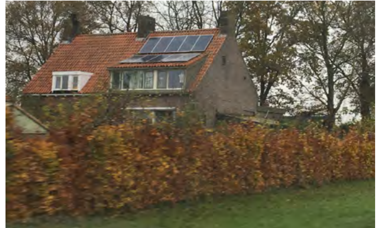
Zonnepanelen op dak, verwaarloosbaar effect
