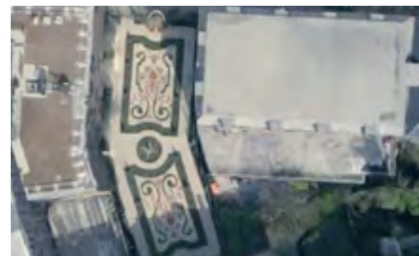
Bovenaanzicht keurtuin Herengracht; geen vergunningvrije bouwwerken zichtbaar.
