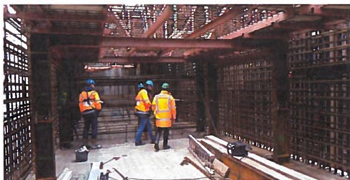
Figuur 24 Foto van de 7 m dikke wand met links en rechts de wandwapening ( Bron: OpenIJ ).
