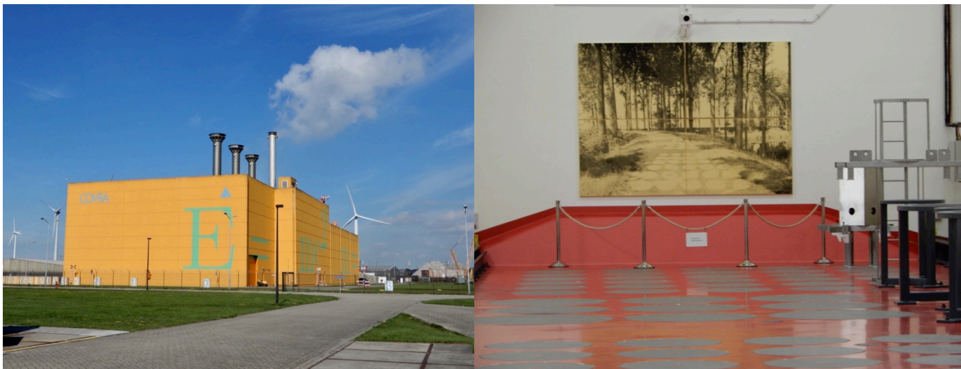
Foto's: Bovengrondse opslag bij COVRA
