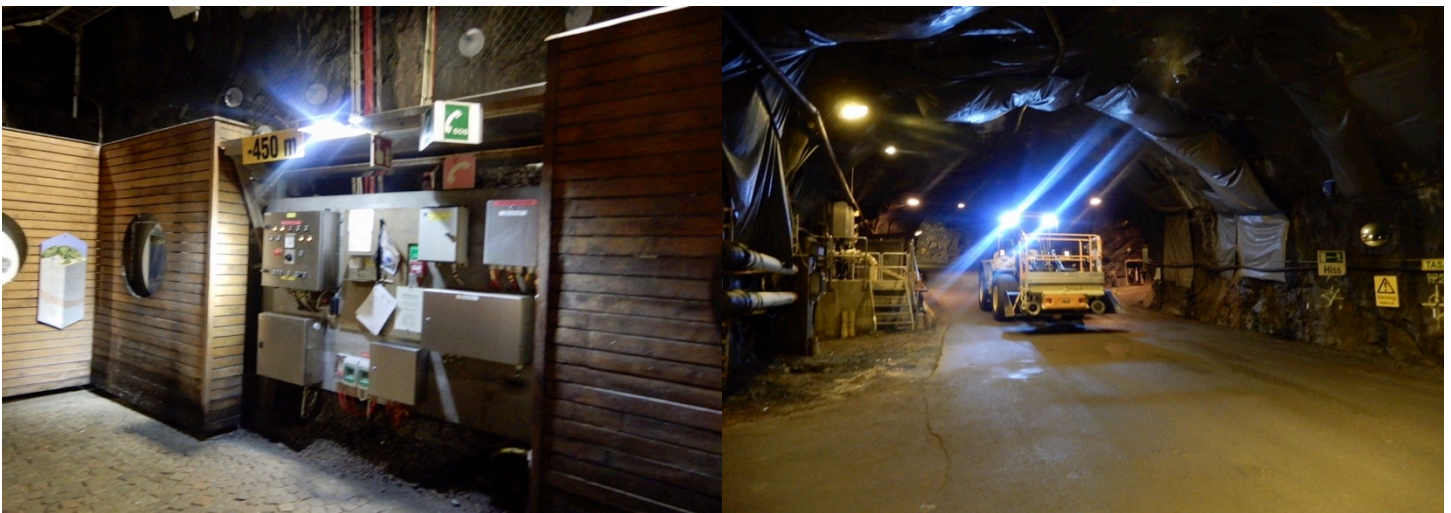
Foto's: Ondergrondse opslag (testlab) in graniet, Äspö (Zweden)
