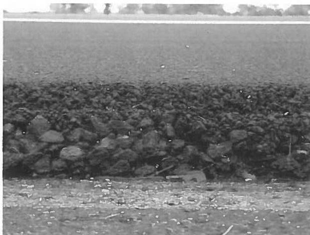
figuur 1 Zijaanzicht van een tweelaags ZOAB
