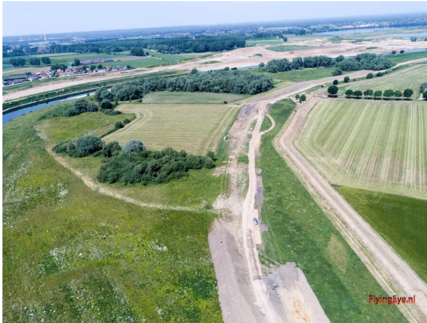
Kadewerkzaamheden bij Grevenbicht met op de achtergrond het project Geistingen (Boertienlocatie)
