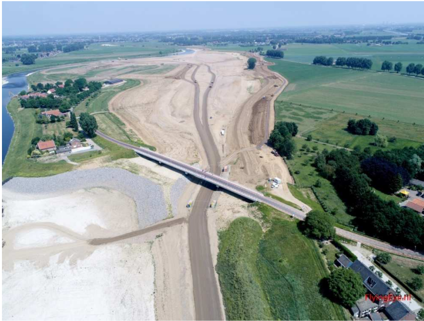
Hoogwaterbrug, rivierverruiming en kadewerkzaamheden bij Visserweert
