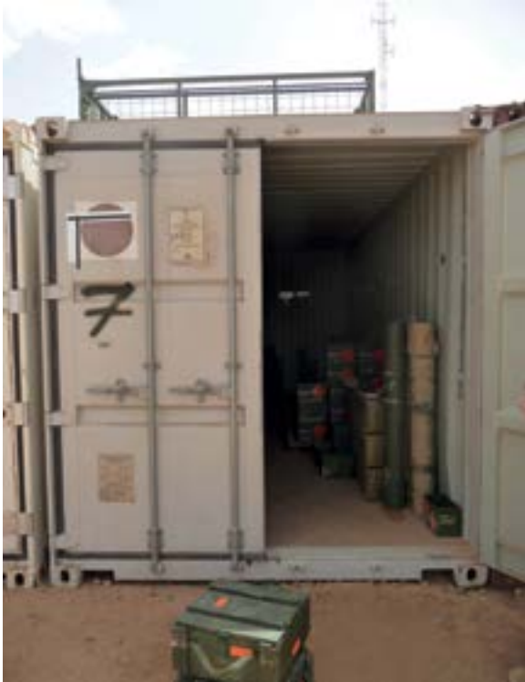
Figuur 29: Container munitieopslag in Kidal zonder zonwerende bescherming.
