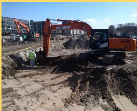
Bodemsanering Spoorzone Delft
