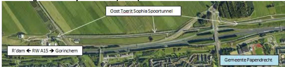
Afbeelding 1.1. Oostelijke toerit Sophia Spoortunnel
