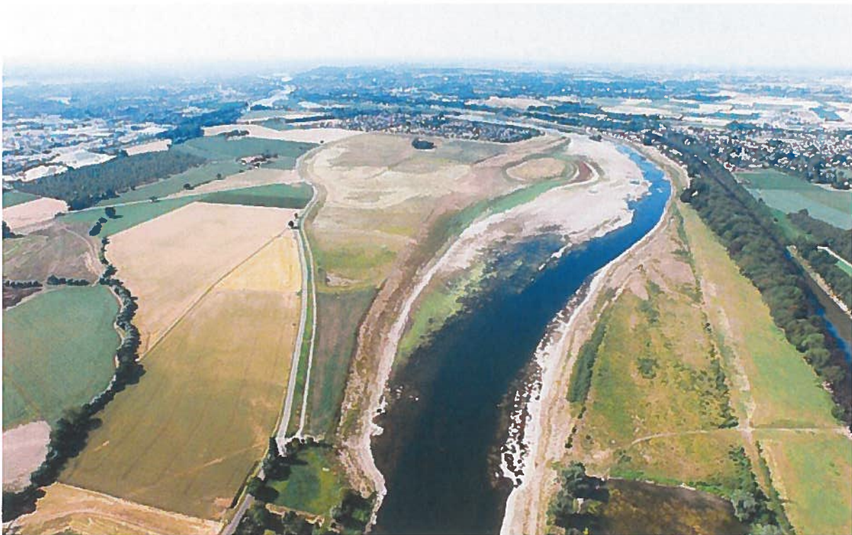
De rivierverruiming in Borgharen op een zomerdag met bijzonder lage waterafvoer. Zoveel ruimte krijgt de Maas er dus bij.
