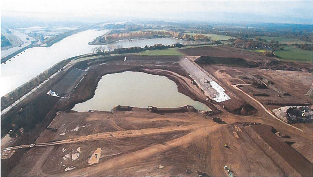
De werkhaven in aanleg in Trierveld.
