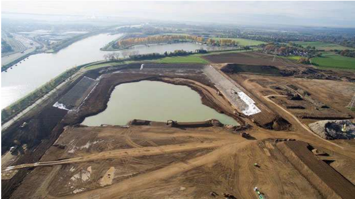
De werkhaven in aanleg in Trierveld.
