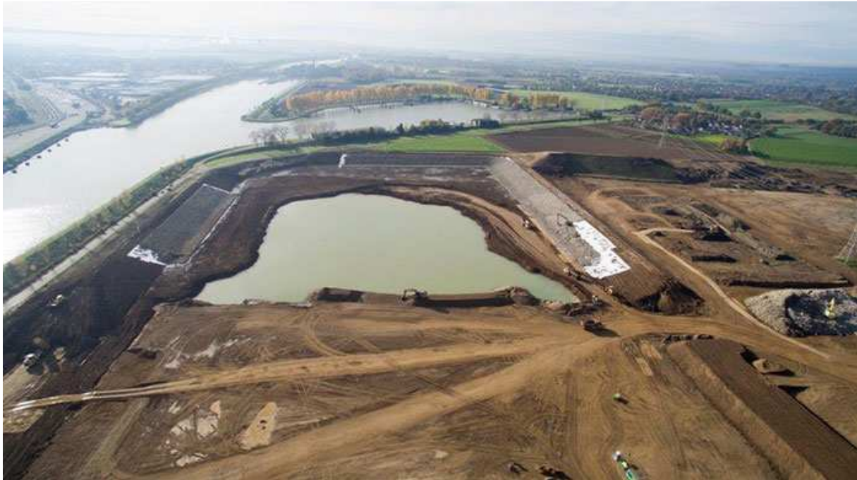
De werkhaven in aanleg in Trienveld.
