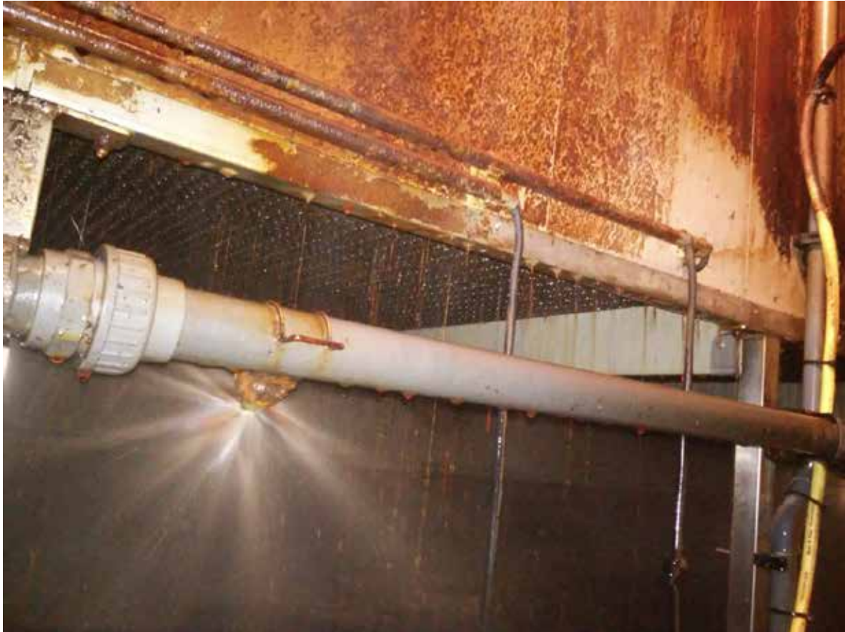
Figuur 12 Stofwasstap type B. De sproeiers zijn zichtbaar die de lucht bevochtigen juist voordat deze door het biowaspakket wordt geleid.
