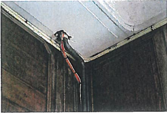
alternatieve kabel- en leidingtracé als gevolg van slechte bereikbaarheid installaties ambtenarenkamer Eerste Kamer
