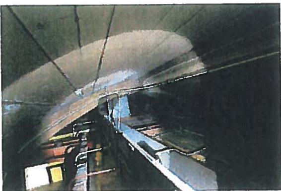
ontbreken brandcompartimenten zolder Eerste Kamer
