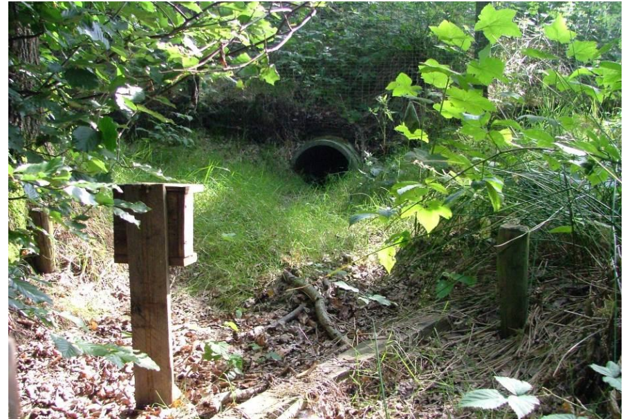
Figuur 5.3: Monitoring van dassentunnel onder de A27 met cameraval (bron: Jaap Mulder)
