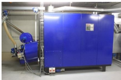
Figuur 8: Houtpelletkachel Oranjatoren te Veenendaal
