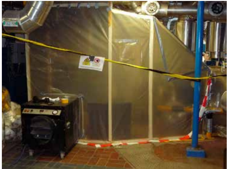
Containment voor sanering slakkenwol met radioactiviteit
