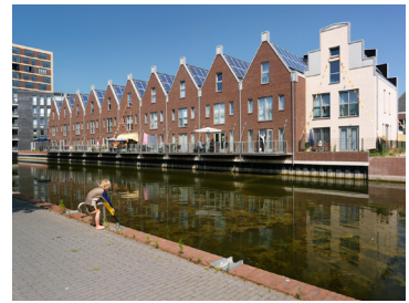
Nieuwbouw en Herstructurering
